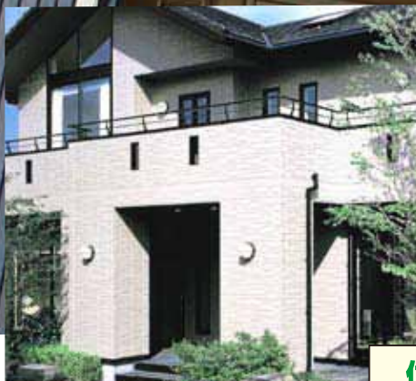
●金属サイディング施工工事
